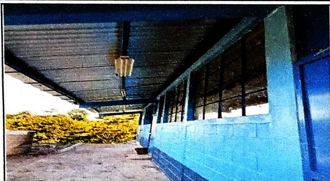
Foto1: Luego de haber realizado los diferentes procesos de mantenimiento del Centro Estudiantil, así mismo se observa la rehabilitación de canales
