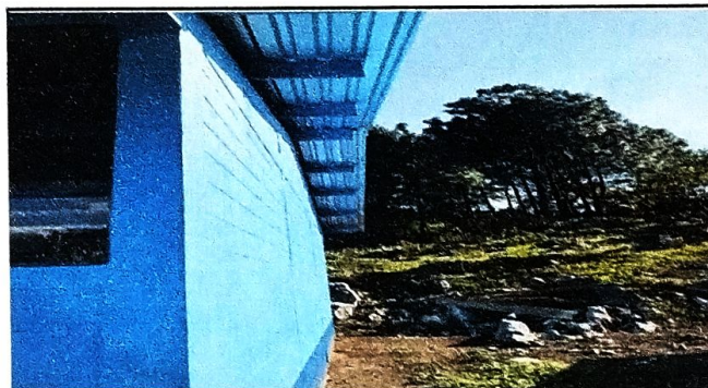
Foto 4: Se observa la finalizacion de aplicación de pintura del modulo II
