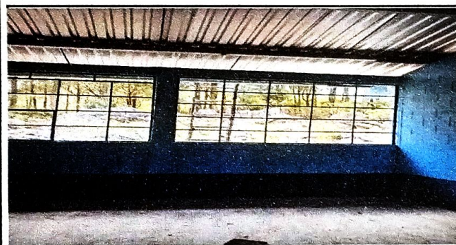
Foto 3: Se evidencia en la imagen la finalizacion de instalacion de ventanales
