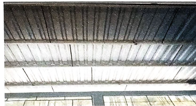
Foto 6: se observa la finalizacion de la instalacion del soporte de metal, así mismo el notorio la finalizacion de la instalacion de laminas troqueladas
